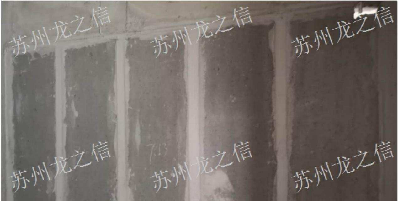
轻质隔墙板具有质量轻、强度高、多重环保、保温隔热、隔音、呼吸调湿、防火、快速施工、降低墙体成本等优点;他的重量只有实心砖墙的八分之一、强度达到C30、热传导率只有实心砖墙的三分之一、声波传导率只有实心砖墙的四分之一、自动调整室内空气湿度、节约工业废渣所侵占的土地、杜绝工业废渣对空气及水源的污染、节约墙体成本的百分之十五至二十、提高施工工效三倍至五倍。轻质隔墙板的安装人工价格，具体还要看你的隔墙面积，面积越大价格会低些，反之会高点。通常情况下双面石膏板的隔墙，起码要25一平方，不是双面展开的平房，是按照单面面积算总平方数。岩棉施工比较低也要5元一平方，合起来大致不低于30元一平方。
